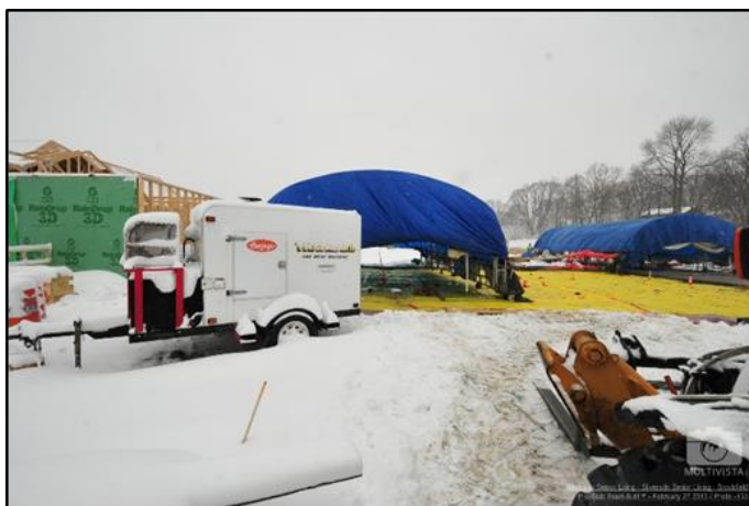
Figure 36 – Cold Weather Pour
